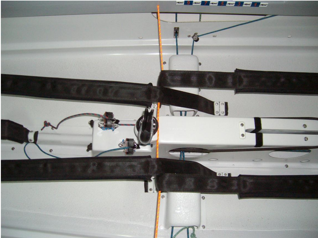
Ilustración 2. Vista de los cinchas y de los protectores de reenvíos en el fondo de la bañera
